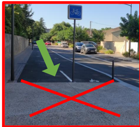
Conflit Piéton/vélo à la sortie de la PC (Insertion)
