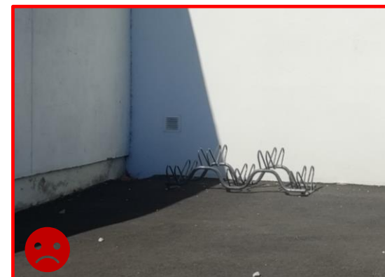
Racks à Pierrelatte
